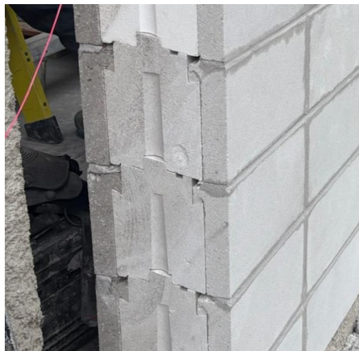
Exemple de chevauchement et de continuité de l'isolant après la découpe au pourtour d'une ouverture
