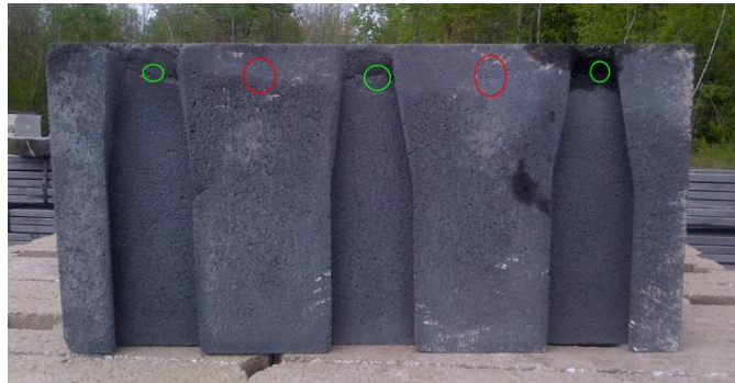
Photo de l'endos d'une plaquette de béton.
