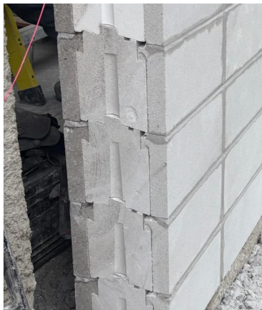
Exemple de chevauchement et de continuité de l'isolant après la découpe au pourtour d'une ouverture
