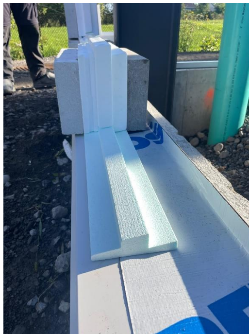
Exemple de montage du bloc de départ
